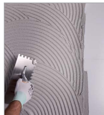
Fig. 13 - Realização da primeira demão de regularização
