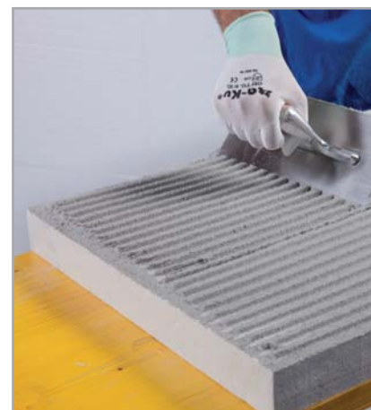
Fig. 6 - Distribuição homogênea do adesivo sobre o reverso do painel isolante
