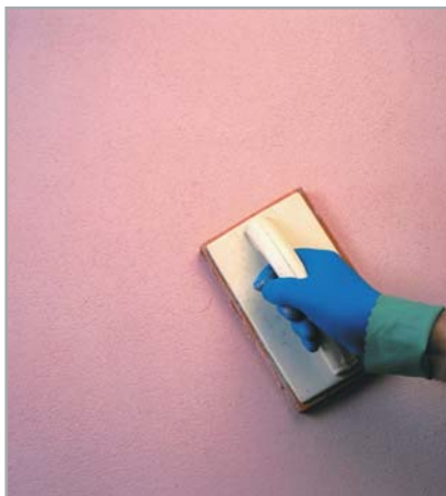
Fig. 17 - Afagamento do Tonachino com talocha de esponja
