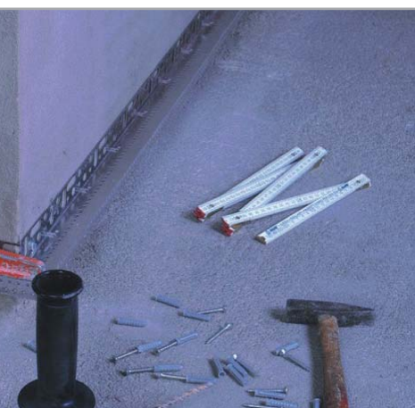
Fig. 4 - Posicionamento do perfil de arranque: assegurar a perfeita horizontalidade com um nível de bolha
