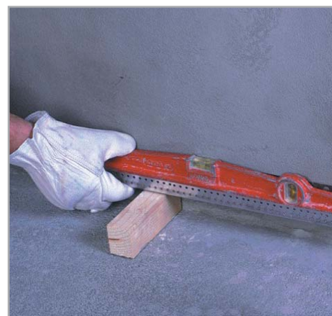
Fig. 3 - Reconstrução do reboco em fase de destacamento com NIVOPLAN + PLANICRETE
