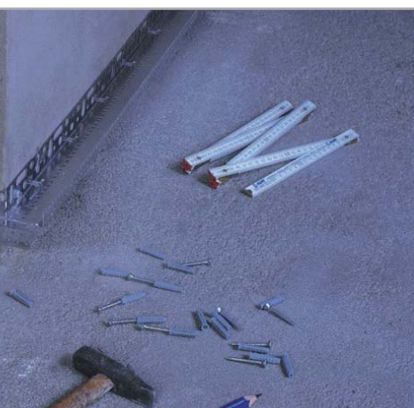
Fig. 5 - Fixação do perfil de arranque com parafuso com bucha expansiva
