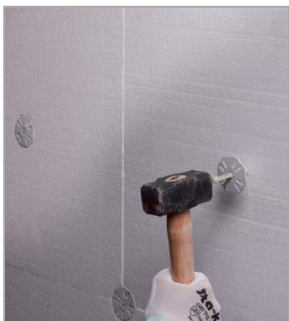
Fig. 11 - Inserção da cavilha
