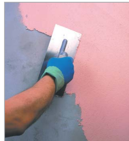
Fig. 16 - Aplicação do Tonachino de acabamento
