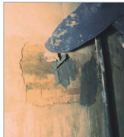
Fig. 3 - Reconstrução do reboco em fase de destacamento com NIVOPLAN + PLANICRETE
