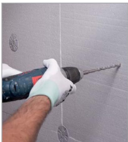
Fig. 10 - Realização do furo para inserção da cavilha
