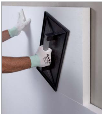
Fig. 9 - Batimento do painel com talocha
