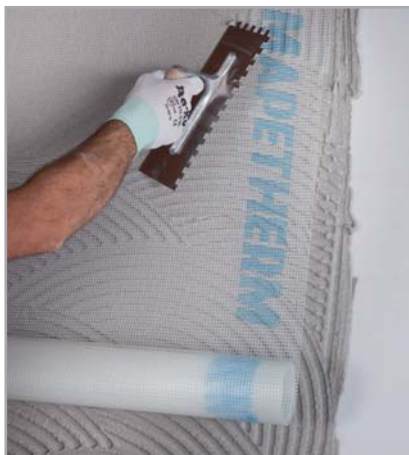
Fig. 14 - Aplicação do MAPETHERM NET
