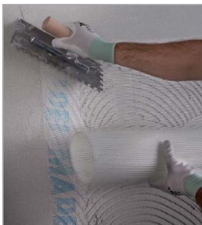
Fig. 15 - Sobreposição das telas de rede em pelo menos 10 cm
